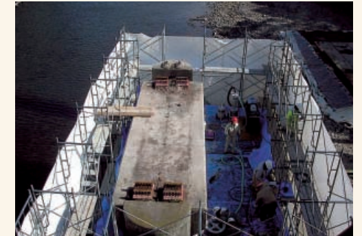
乾式ワイヤーソー 福岡県筑後市施工風景
