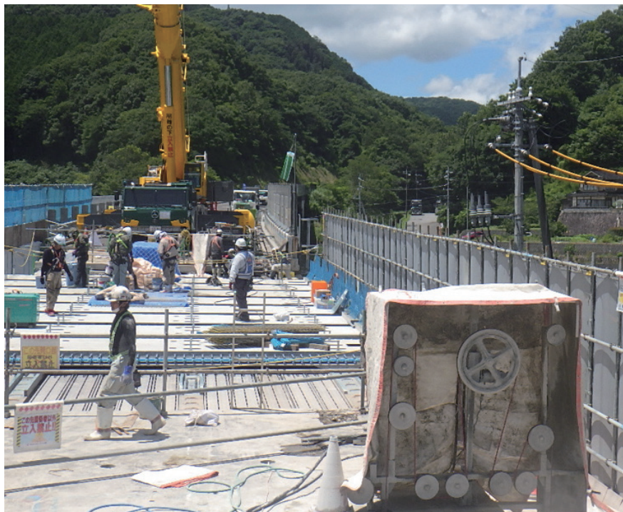
高速道路のリニューアル工事
